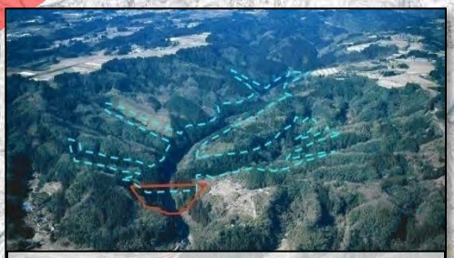
玉来ダム(工事予定箇地)
