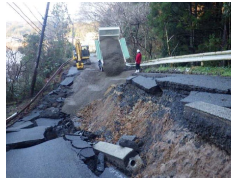
鳳珠郡穴水町川尻地内 道路啓開
