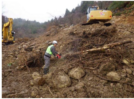
輪島市三井町地内 道路啓開
