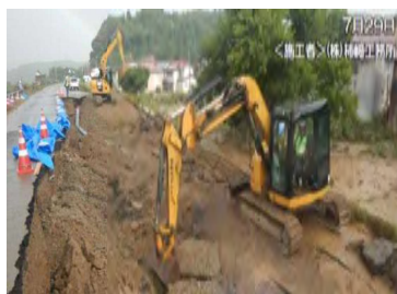
国道47号戸沢村 被災構造物撤去
