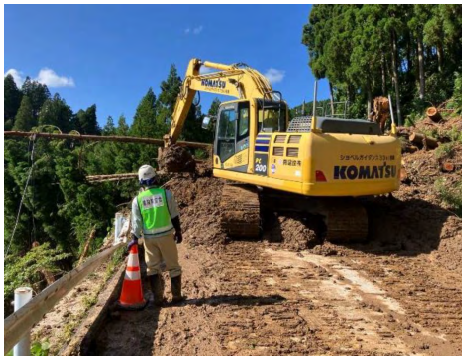
輪島市門前町地内 道路啓開
