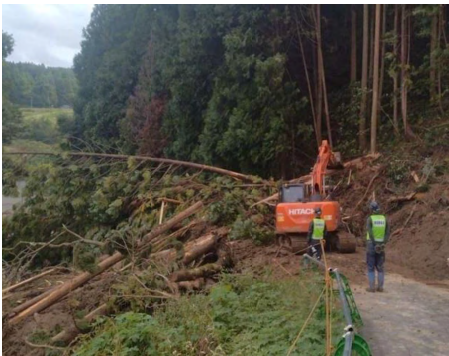
輪島市門前町地内 道路啓開
