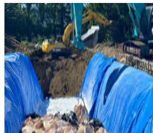
栃木県内豚熱発生に係る掘削、埋却、埋め戻し、消石灰の散布
