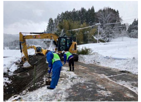
輪島市町野町金蔵地内 道路啓開
