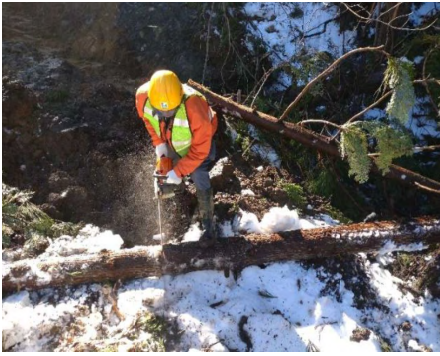
輪島市門前町二又川地内 道路啓開
