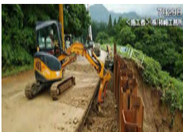
国道47号舟形町 矢板打設、盛土
